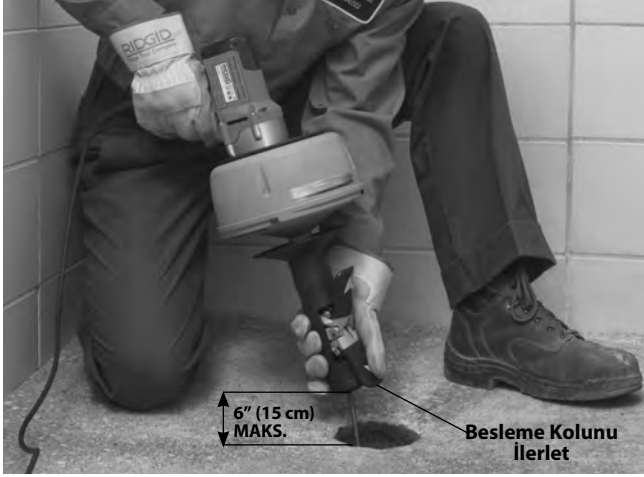
Şekil 10 – Kablunun AUTOFEED İle Beslenmesi
